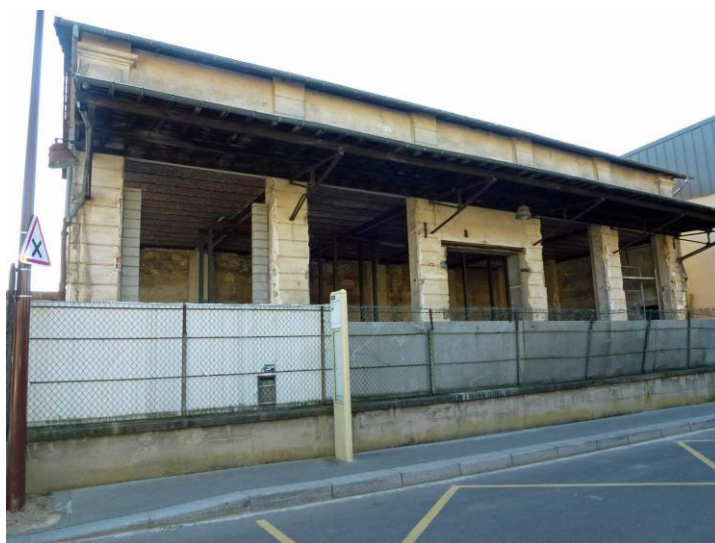
Mars 2021 - État d'avancement de la maison de santé
